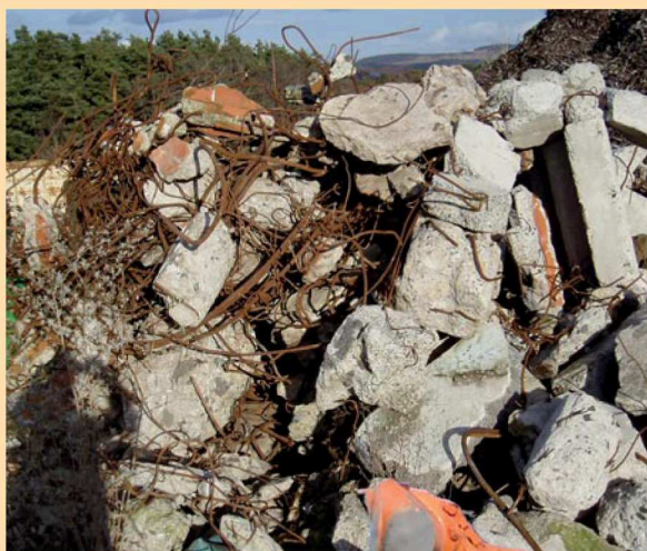
Gravats en attente de concassage
